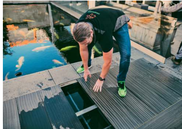
DYNUM TERRASSENDIELE Farbe Nigella
