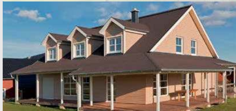
► Bevelprofil Sandelholz | Architektur: Werner Rümmele Freier Architekt, Ochsenhausen
