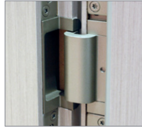
Detail verdecktes Band für gefälzte Türen
