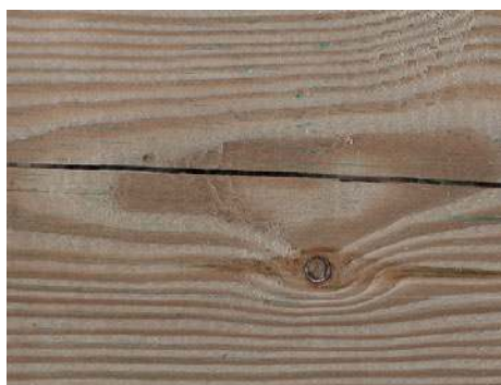
Spannungsrisse durch die Holz Trocknung
