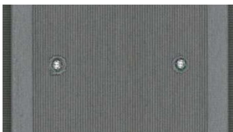
Produktionsrückstände an den Verschraubungen der JUMBO WPC Profile
