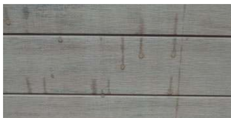
Fleckenbildung durch von Regen angelöste Partikel
